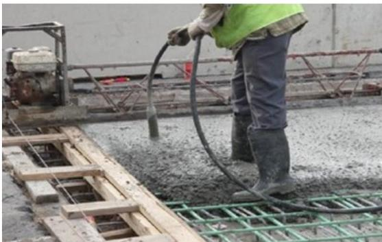
Figure 1. Vibration d'un béton à l'aiguille.
