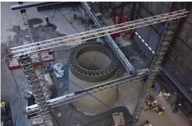
Figure 4. Construction par impression 3D d'un élément d'éolienne
